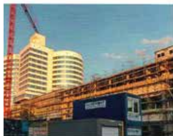
UKM Münster Sanierung der Bettentürme Ost und West Heizungs-, Lüftungs-, Kälte-, Sanitärtechnik
